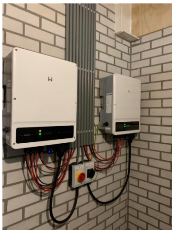
2x omvormers 15kwh
